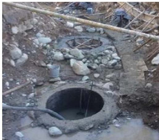
Anillos en concreto
