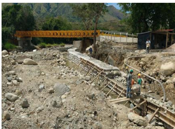
Construcción de bolsacretos
