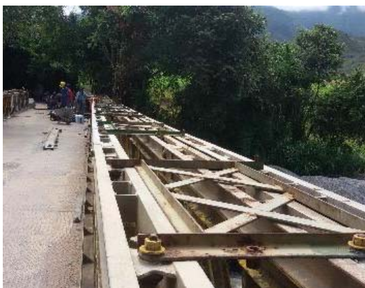
Instalación de elementos metálicos para puente en intervención
