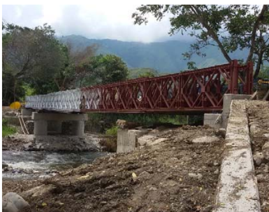
Sandblasting y pintura
