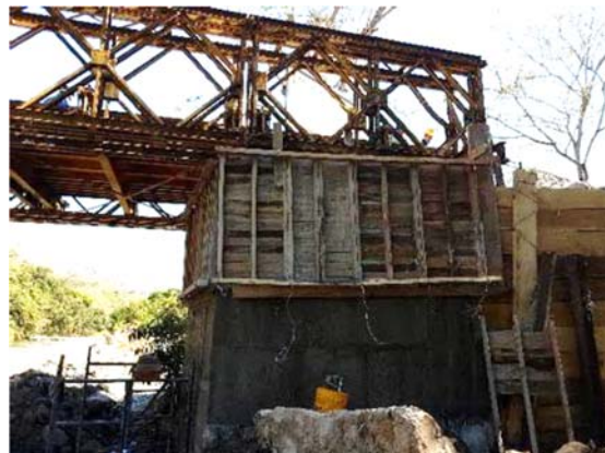
Encofrado de estribo con concreto ciclópeo
