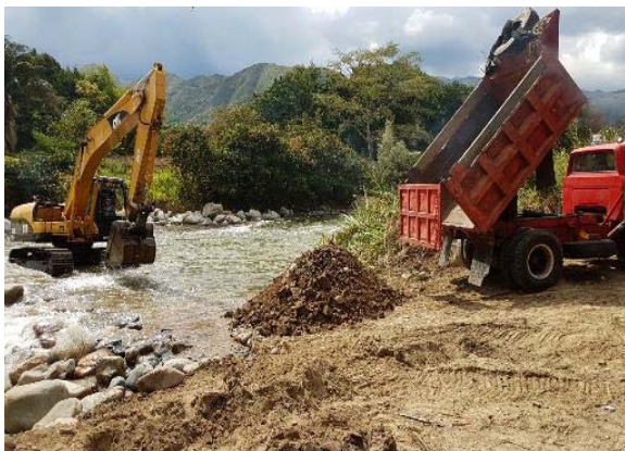
Adecuación de tramo para paso provisional de vehículos
