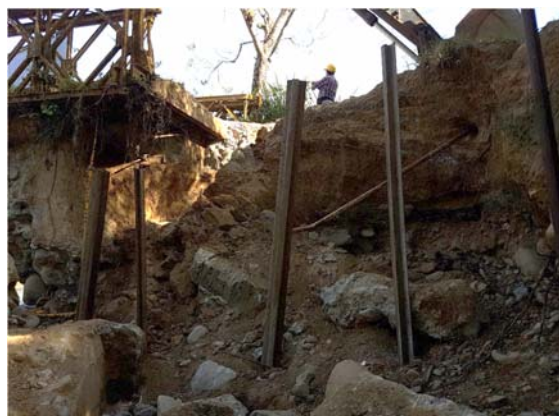
Apuntalamiento con rieles
