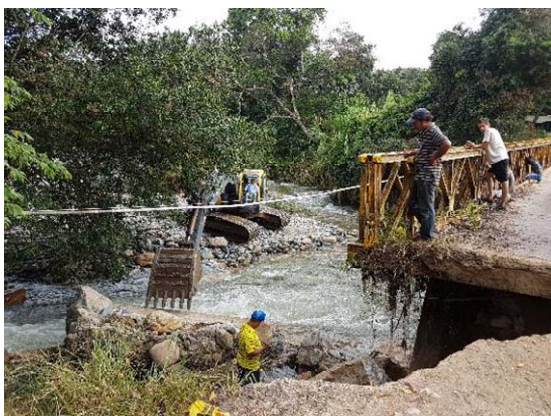
Dragado del lecho del río
