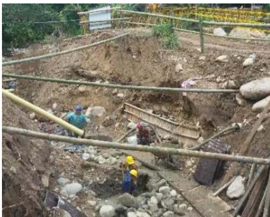
Aplicación de concreto ciclópeo para contención de tramo de sendero peatonal
