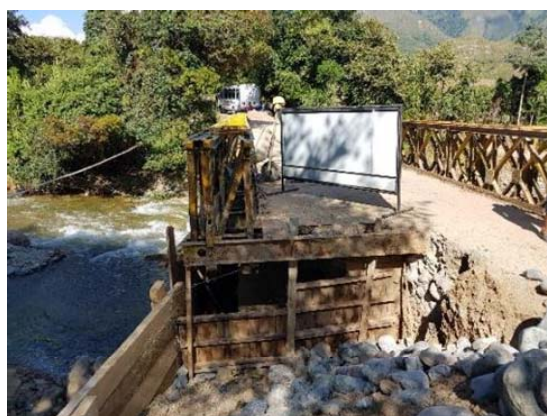
Relleno de tramo para recuperación de tramo socavado
