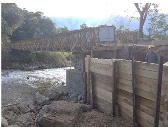
Entibado en madera para recuperación de tramo de banca
