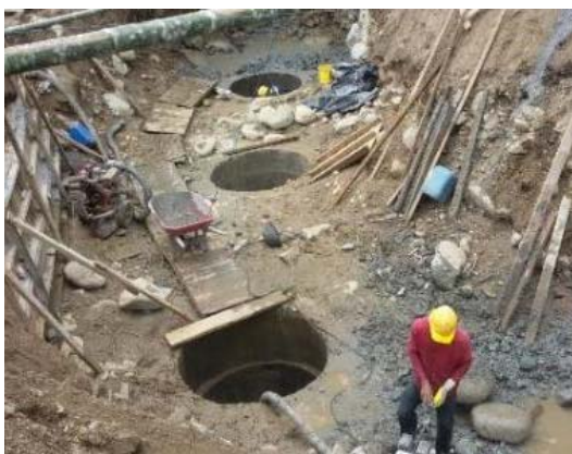
Excavaciones para caisson
