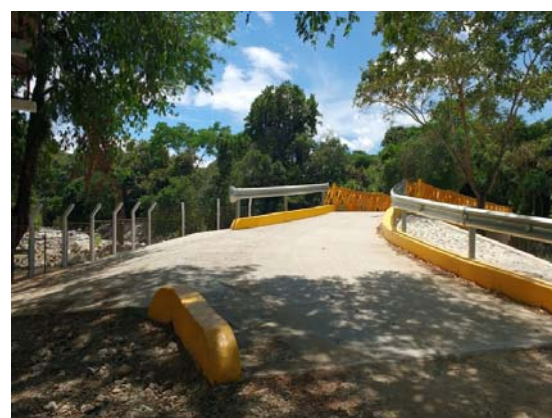
Acceso en concreto, bordillos y barandas
