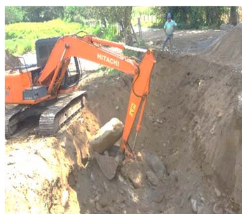
Excavaciones para explanación y replanteo de cimentación a construir
