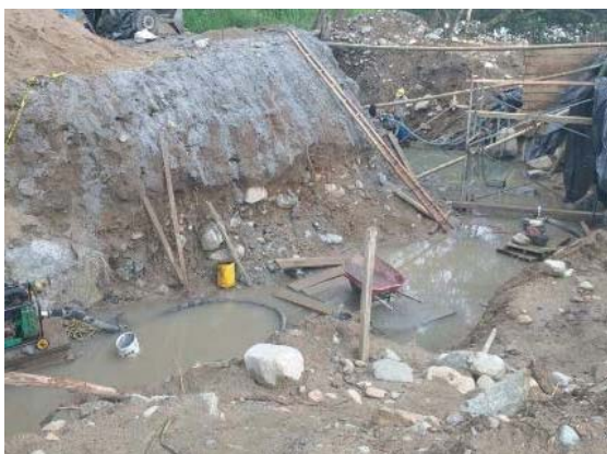
Manejo de aguas en el frente de obra
