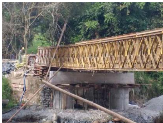
Construcción pilotes y vigas
