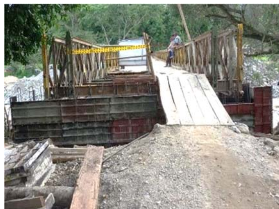
Tramos provisionales de puente
